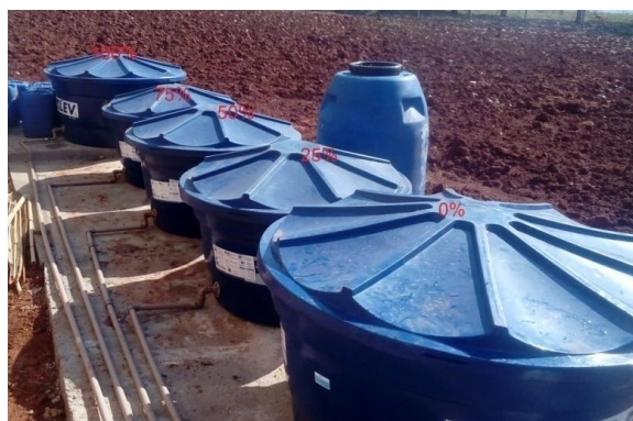
Figura 3. Reservatórios de água e efluente
