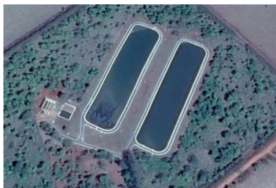
Figura 2. Estação de tratamento de efluentes (ETE), Ceres – GO.
